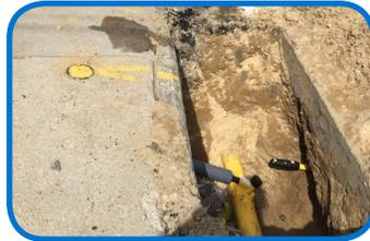
Las líneas de servicio de gas natural se ejecutan desde la parte principal fuera de su hogar y se conectan al medidor de gas que sirve a su hogar o negocio. Después de instalar una nueva tubería principal (Paso 3), también será necesario reemplazar las líneas de servicio, que Reexcavación de la calle.
